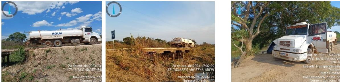
Fig. 02: Dia 20/10/2021. Atividades com caminhão pipa nas Pontes 71 e 72. Abastecimento da Ponte 72; Abastecimento da Ponte 71; Captação de água no rio Pixaim.
