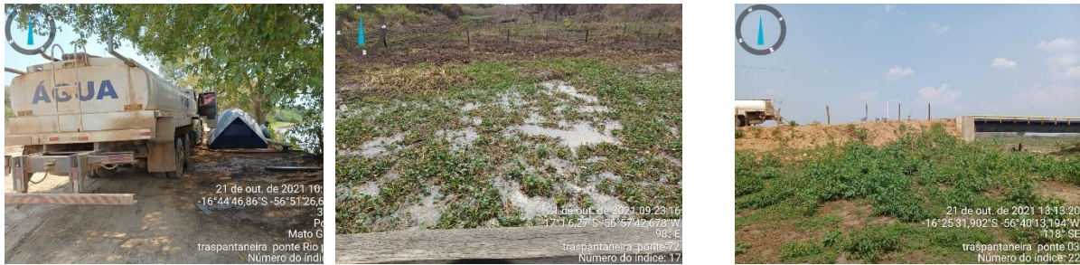
Fig. 03: Dia 21/10/2021. Atividades com caminhão pipa nas Pontes 72 e 03. Captação de água no rio Pixaim; Abastecimento da Ponte 72; Abastecimento da Ponte 03.
