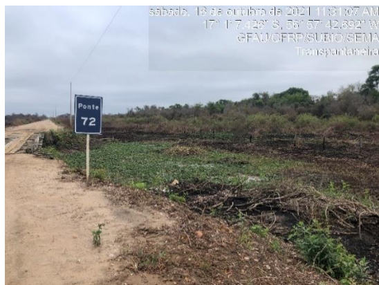
Vegetação na ponte 72
