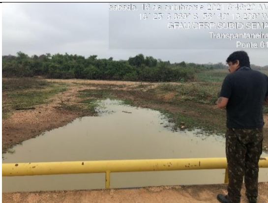
Vistoria da ponte 03
