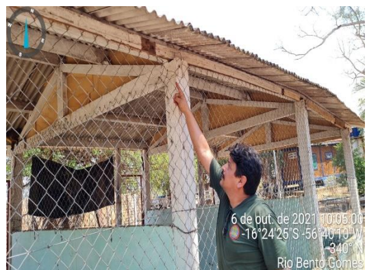
Figura 10: Vistoria nas estruturas dos recintos, no posto da SEMA, no Km 17 da transpantaneira.
