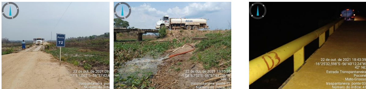
Fig. 04: Dia 22/10/2021. Atividades com caminhão pipa nas Pontes. Abastecimento da Ponte 72; Abastecimento da Ponte 72; Abastecimento da Ponte 03.
