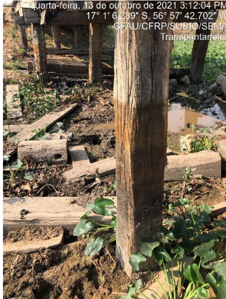
Réguas de nivelção da ponte 72.
