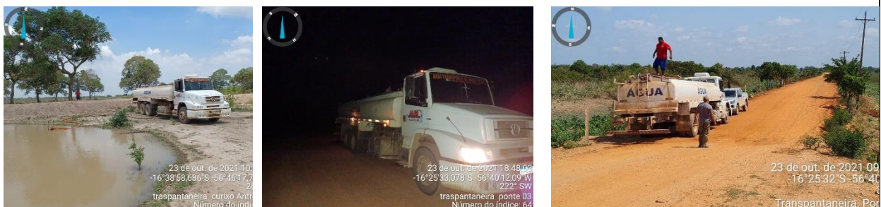
Fig. 05: Dia 23/10/2021. Atividades com caminhão pipa na Ponte 03. Captação de água no Corixo Antrópico; Abastecimento da Ponte 03; Abastecimento da Ponte 03.
